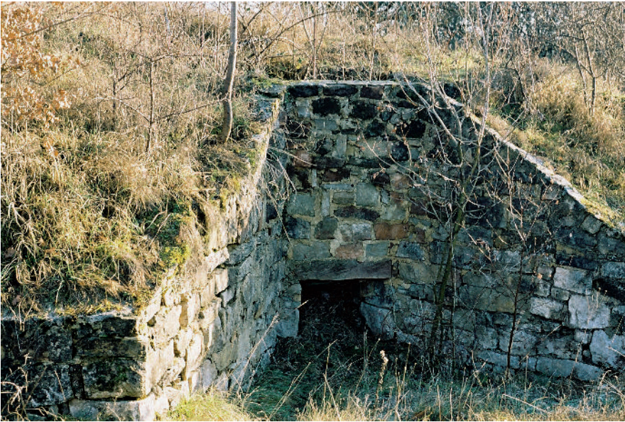
Abb. 2: Kalkofen der einstigen Brennanlage bei Riesweiler. Der rechte der beiden ca. 2,10 m hohen Trichter- schachtöfen besitzt an sei- nem oberen Rand einen Durchmesser von rund 2,15 m. Bis zur Ofensohle reduziert sich der Schacht- durchmesser um fast einen Meter. Das Mundloch hat eine Größe von ungefähr 70 x 50 cm. Rund 20 Jahre nach ihrer Freilegung wird die Anlage durch den unge- hinderten Bewuchs in zu- nehmendem Maße beein- trächtigt.
