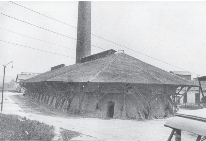
Abb. 5: Ehemaliger Ringofen in Blickweiler. Das Ofenge- bäude besaß eine Länge von etwa 40 bis 50 m. Der 62 m hohe Schornstein war rund 50 Jahre lang ein Wahrzeichen des Ortes. (Foto: Ludwig Weber)
