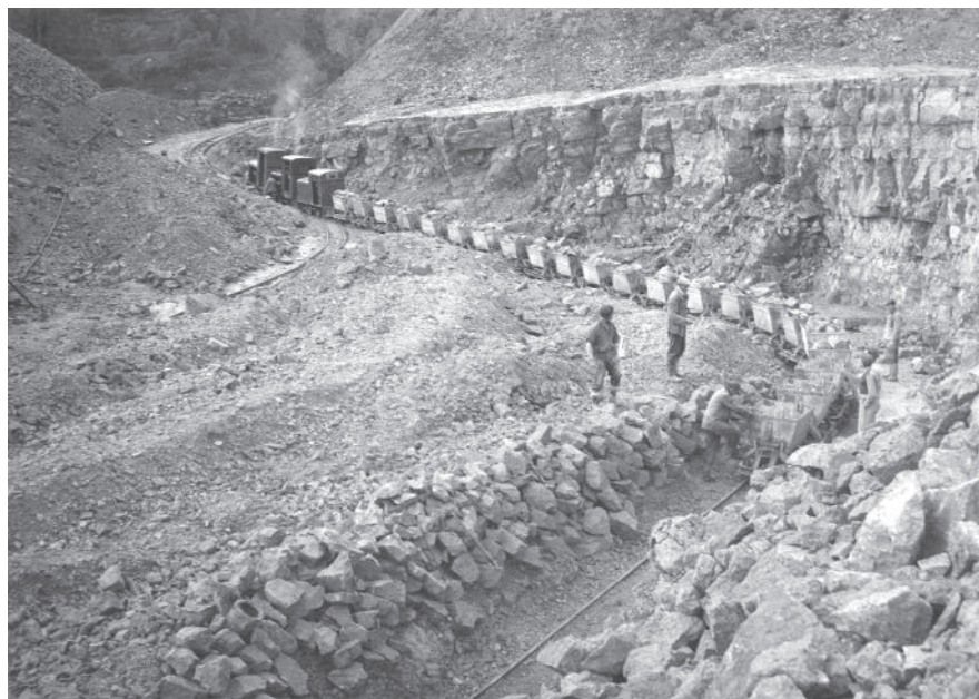
Abb. 10: Früherer Kalksteinbruch auf dem Birzberg zwischen Fechingen und Bübingen. Um die gewonnenen Rohsteine direkt in Kipploren laden zu können, wurden bis an den Fuß der Abbauwand Gleise verlegt. Diesell-
