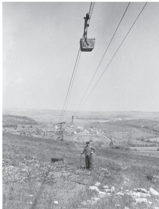
Abb. 3: Frühere Seilschwebbahn vom Kalksteinbruch auf dem Kalbenberg bei Ballweiler zum Ringofen in Blickweiler. Die Fördereinrichtung überwand auf einer Strecke von 2873 m einen Höhenunterschied von 146 m. Die im Bliesgau errichteten Schwebbahnen arbeiteten gemeinhin mit einem durchgehenden – an den Endstationen über Seilscheiben geführten – Zugseil sowie zwei getrennten Tragseilen, einem dünneren für die Berg- und einem dickeren für die Talfahrt. (Foto: Ludwig Weber)
