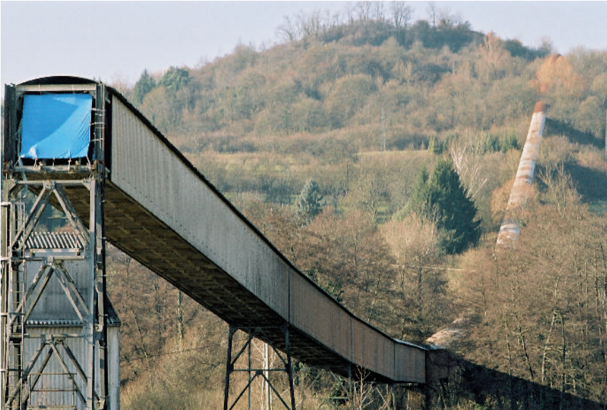
Abb. 6: Stillgelegte Förderbandbrücke in Gersheim. In den 1960er Jahren wurde die Seilschwebbahn zwischen der Abbaustätte auf dem Lohberg und dem an die Bliestalbahn angeschlossenen Kalkwerk durch eine moderne, überdachte Förderbandanlage ersetzt. Auch nach dem Einstellen der Branntkalkproduktion und dem Abriss des letzten Kalkofens stellte diese Transporteinrichtung bis zu ihrem Rückbau im Sommer 2005 ein markantes Bauwerk im südlichen Bliestal dar.
