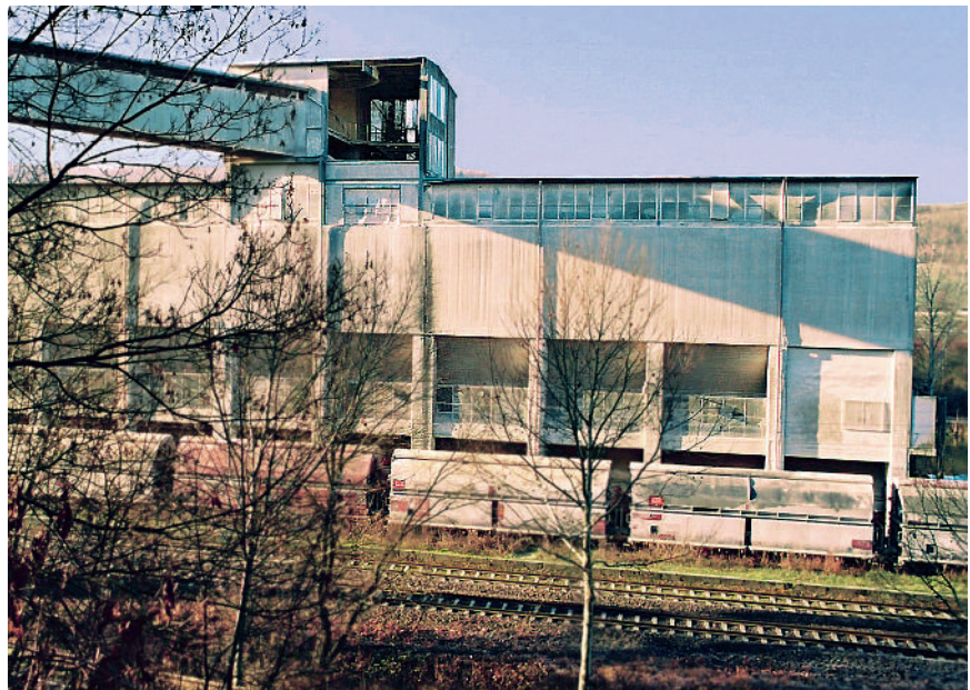
Abb. 9: Verladesilo der Kalksteingrube Auersmacher. Das Silo für die Bahnverladung war ursprünglich auf ein Fassungsvermögen von 2400 Tonnen Rohstein ausgelegt. Aufgrund unausbleiblicher Ablagerungen hat sich die faktisch nutzbare Aufnahmekapazität im Laufe der Zeit auf rund 1500 Ton-
