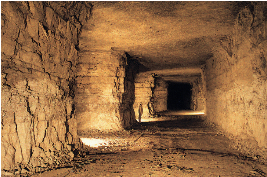
Abb. 8: Kammer-Pfeiler-Bau in der ehemaligen Kalksteingrube Gersheim. Zwischen jeweils zwei parallelen, im Bohr- und Sprengbetrieb aufgefahrenen Strecken blieb die Lagerstätte zunächst unangetastet. Diese als Festen bezeichneten Bereiche wurden danach in annähernd konstanten Abständen durch so genannte Querörter un-
