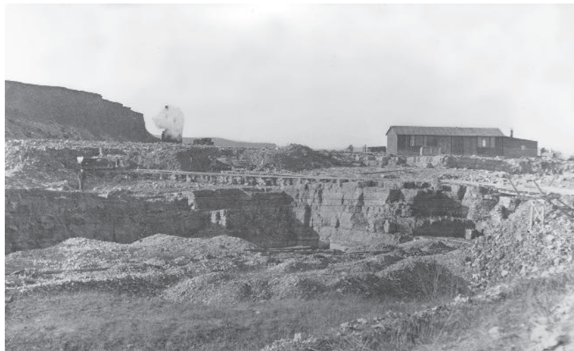
Abb. 4: Großflächiger Kalksteinbruch auf dem Kalbenberg südöstlich von Ballweiler. Durch den Abbau wurde die markante Schichtstufe im Bereich des Trochitenkalks künstlich versteilt. Vor der um 1909 erfolgten Umstellung auf Bohr- und Sprengbetrieb wurde der Kalkstein in mühevoller Handarbeit aus dem Anstehenden herausgebrochen. Seit 1991 ist das aufgelassene Steinbruchgelände ein Naturschutzgebiet. (Foto: Ludwig Weber)
